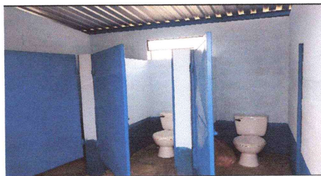
Foto 6: baño: se observa la remodelacion de las puertas de los baños.
