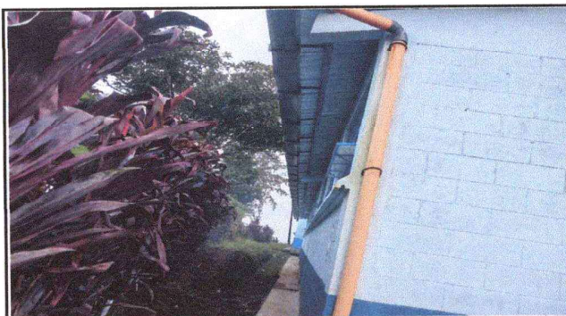
Foto 4: Atrás del edificio: canales puesta y protegiendo la banqueta.
