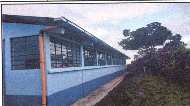
Foto 2: Módulo 1: Canales y bajadas de agua pluvial ya terminado.
