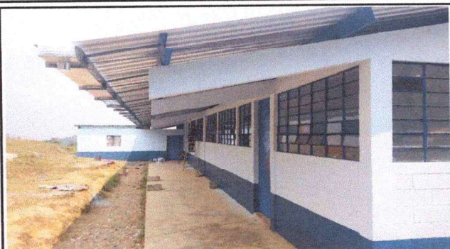
Foto 1: Módulo 1: Estructura de techo ya terminado.
